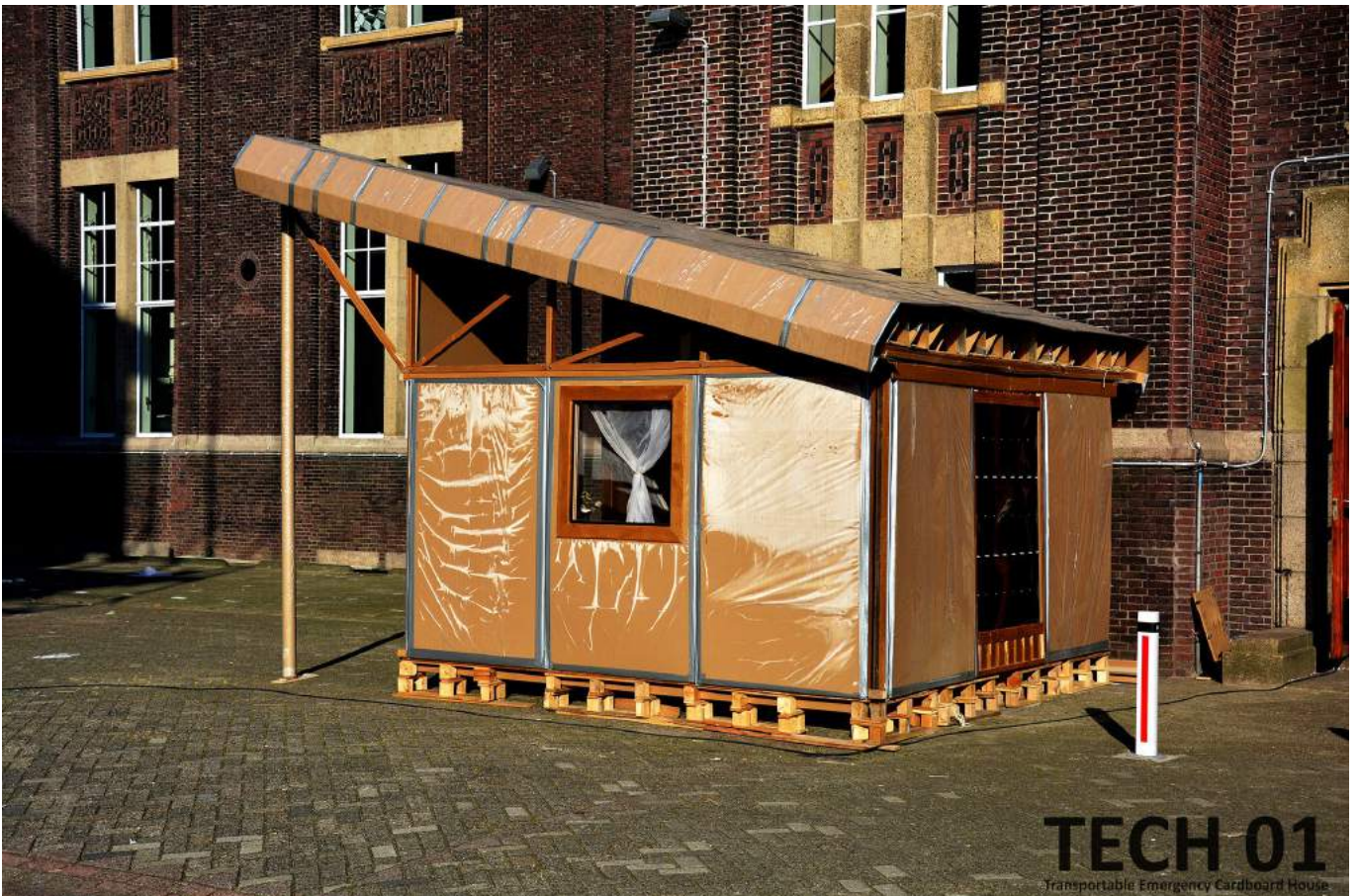
prototyp konstrukcji domu dla uchodźców Bucky Lab TU Delft, 2015.
